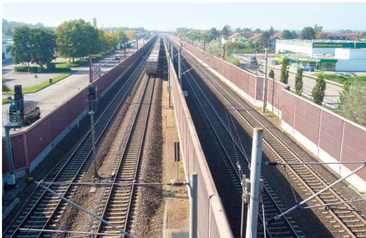
Ausgebaute Rheintalbahn mit Lärmschutz zwischen Offenburg und Baden-Baden Foto: Thomas Ullrich
