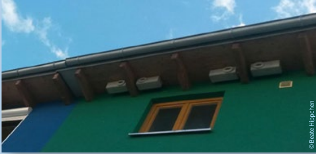
Mauersegler-Nistkästen unter dem Dach in Freiburg.
